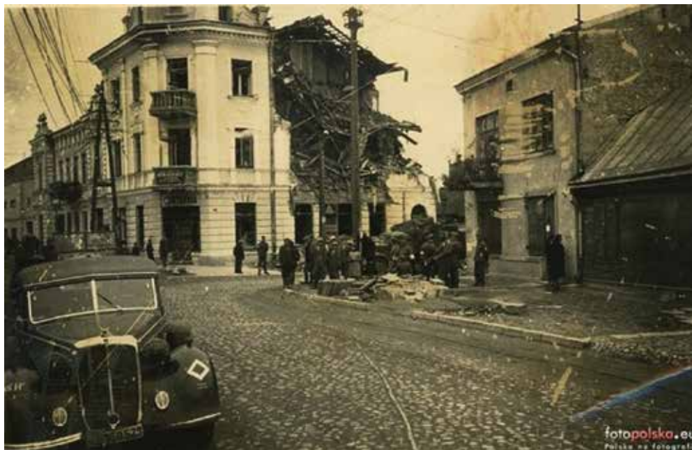
Ryc. 9. Zniszczona kamienica Mieczkowskiego.
