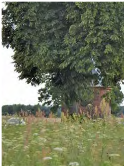
3. Kapliczka w Trzciance, stan przed przeniesieniem, widok od strony południowo-zachodniej, październik 2016 roku.
