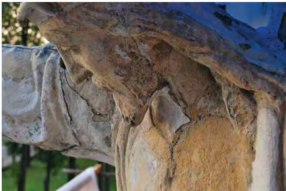
Fot. 5. Zbliżenie na fragment rzeźby Chrystusa w trakcie prac konserwatorskich. Fotografia ukazuje głębokie ubytki w partii torsu powstałe na skutek zastosowania w przeszłości uzupełnień cementowych.
