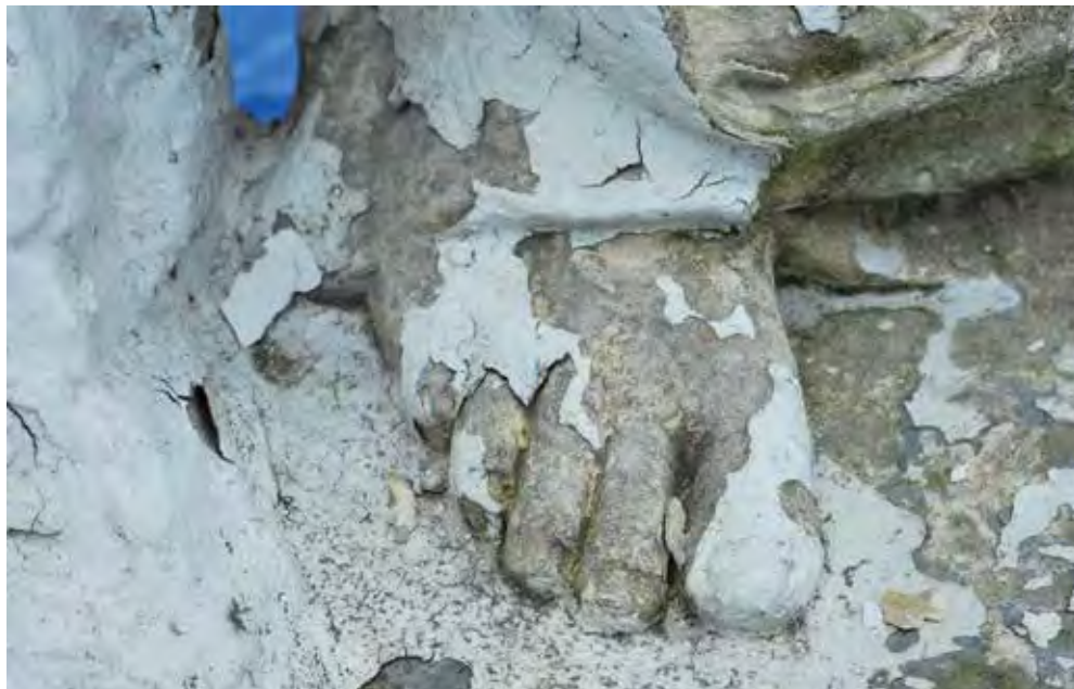
Fot. 7. Zbliżenie na podstawę i stopę Chrystusa. Widoczne warstwy wtórnej farby pokrywającej powierzchnie kamienne. W partiach szat można zauważyć, że złuszcząca się z posągu farba odpadała wraz z powierzchniowymi warstwami kamienia.
