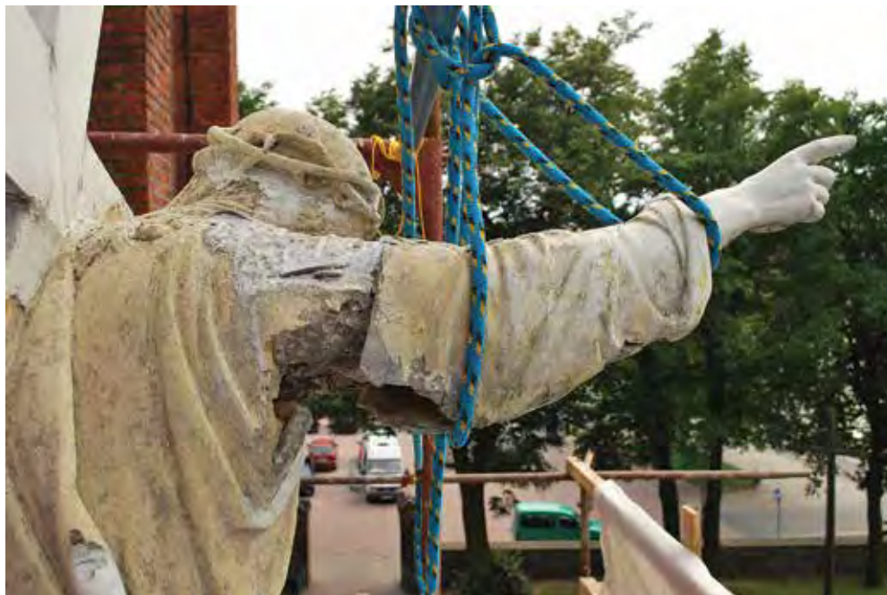
Fot. 3. Cynkowy odlew ręki Chrystusa w trakcie demontażu. Na zdjęciu widać uzupełnienia cementowe i zniszczenia w partii ręki powstałe na skutek niewłaściwych napraw.
