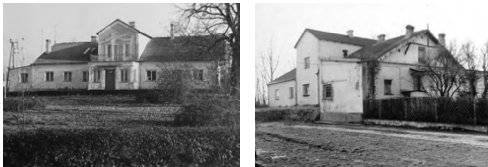
Ryc. 66-67. Elewacja frontowa oraz elewacja ogrodowa dworu w Trynosach w 1984 r.
