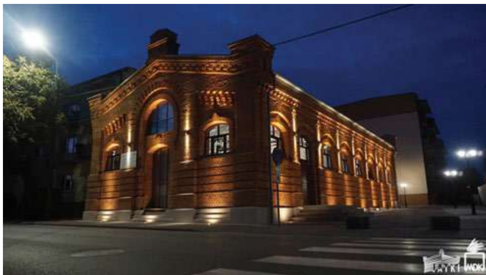
Zdj. 9. Budynek Jatek po remoncie
