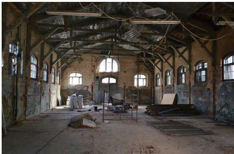
Zdj. 2. Jatki w trakcie rewitalizacji
