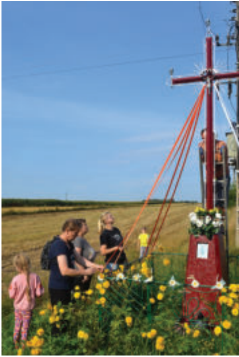
Ryc. 1. Prace przy pierwszym krzyżu w Świerżach-Kończanach.
