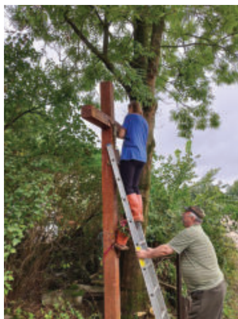
Ryc. 8. Prace przy trzecim krzyżu w Świerżach-Kończanach.
