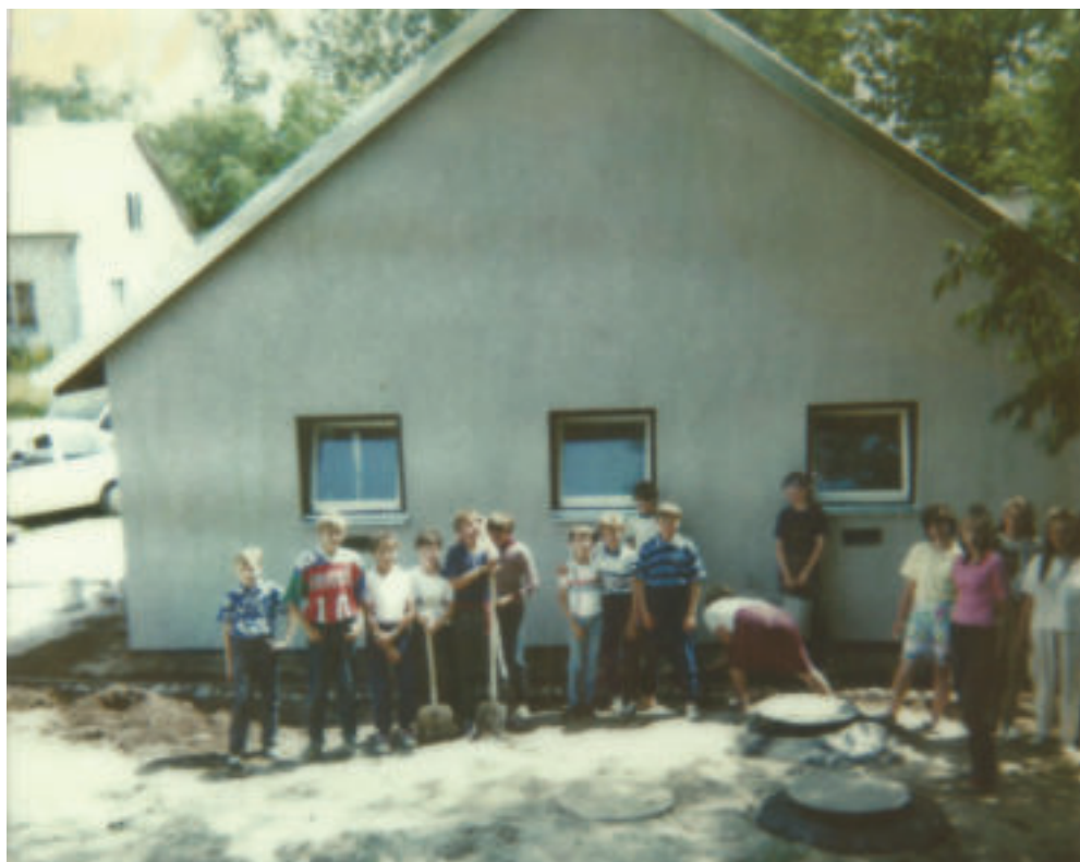
Ryc. 20. „Mamy oczyszczalnię ścieków typu biologicznego” - 23.06.1992 r.
