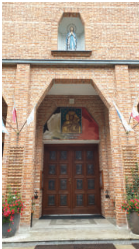
Ryc. 19. Fragment fasady osuchowskiego kościoła z drzwiami głównymi.
