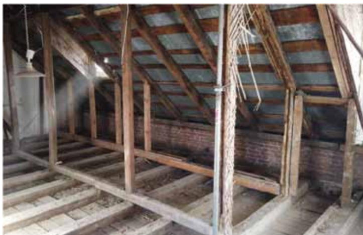
Ryc. 2. Prace remontowe wewnątrz budynku Biblioteki. ►
