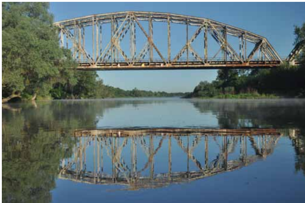
Ryc. 1. Most kolejowy nad rzeką Bug widziany z kajaka.
