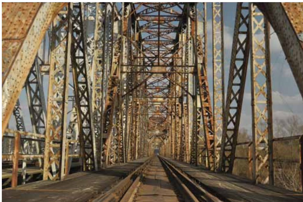
Ryc. 4. Tory na stalowej konstrukcji mostu we Fronołowie.
