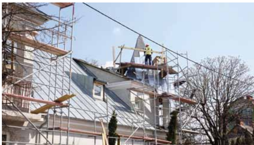
▲ Ryc. 1. Prace remontowe na dachu budynku MBP.
