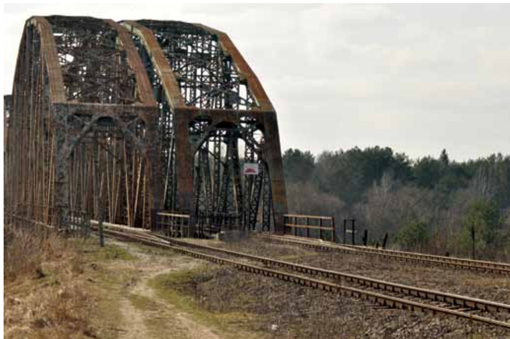
Ryc. 3. Dwa przełoty stalowego mostu.
