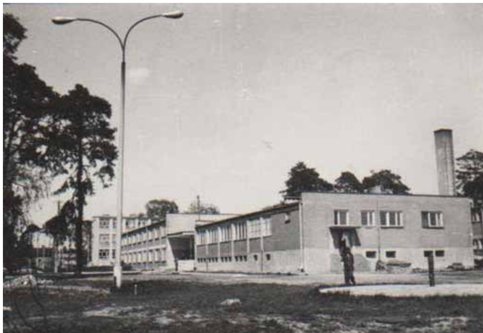
Ryc. 6. Rok 1969 – budynek internatu na 200 miejsc, którego budowę ukończono w roku 1967.
