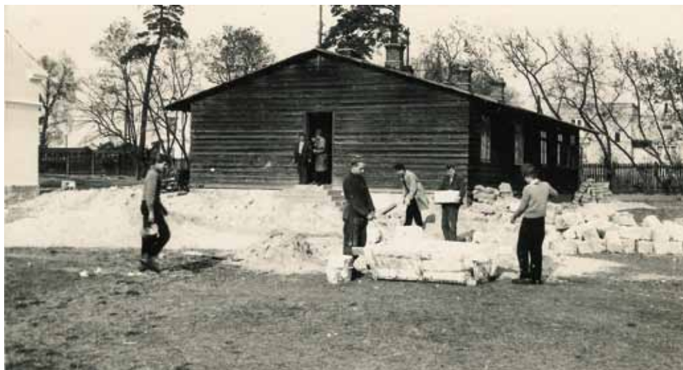
Ryc. 1. Dawny budynek szkoły przy ulicy Nurskiej 27 w Małkini Górnej podczas przebudowy – początek lat 60-tych XX wieku.
