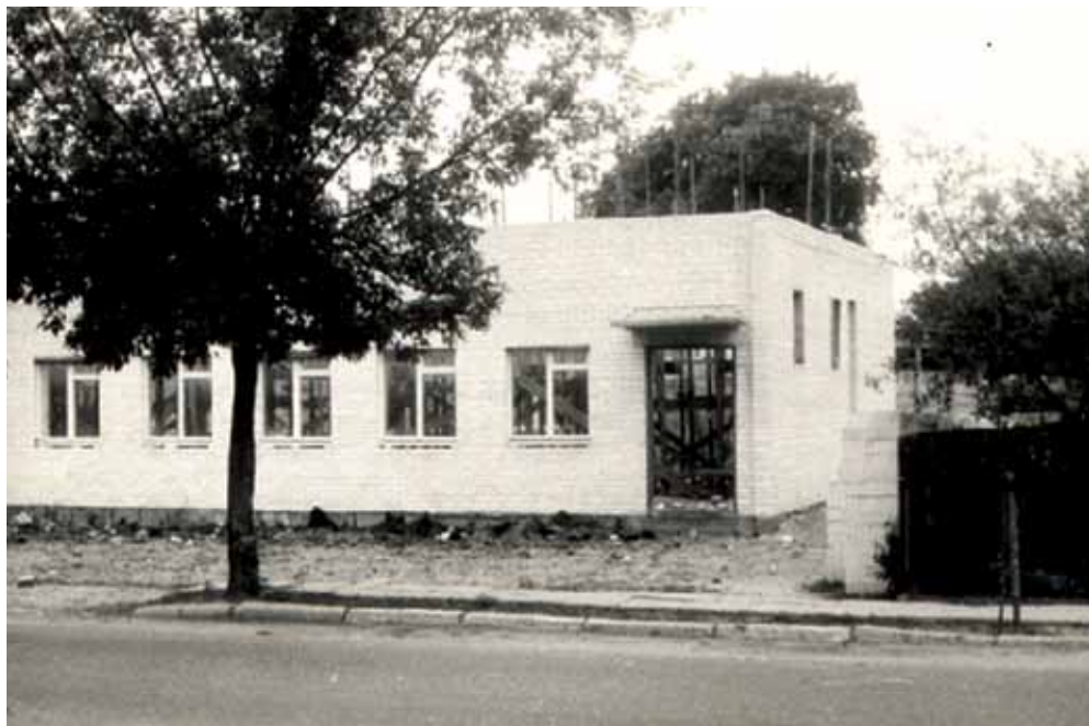
Ryc. 26. Dom Strażaka w budowie (początek lat siedemdziesiątych).
