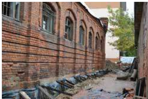
Zdj. 2. Osuszanie ceglanych fundamentów.
