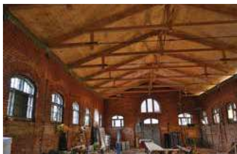
Zdj. 3. Po usunięciu boksów pokazało się w całej okazałości halowe wnętrze JATEK. Na zdjęciu etap remontu po położeniu nowej więźby dachowej i pokrycia z blachy o wysokim stopniu odporności.
