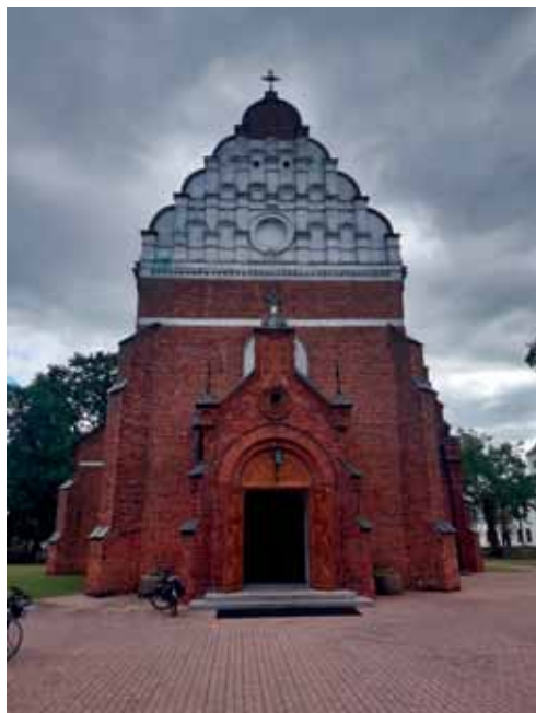
Ryc. 19. Widok frontowej elewacji kościoła pw. św. Andrzeja w Broku.
