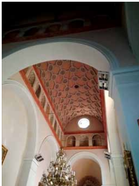
Ryc. 20. Kolebkowe sklepienie w kościele parafialnym pw. Św. Andrzeja w Broku.
