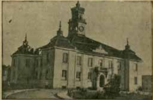
Nowobudowany gmach magistratu w m. Ostrowi-Mazowieckiej.
