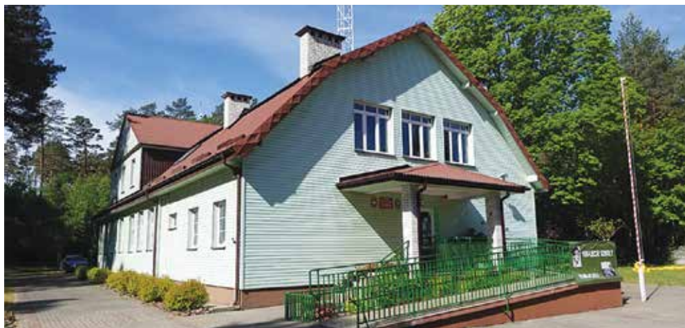
Ryc. 2. Budynek szkoły obecnie
