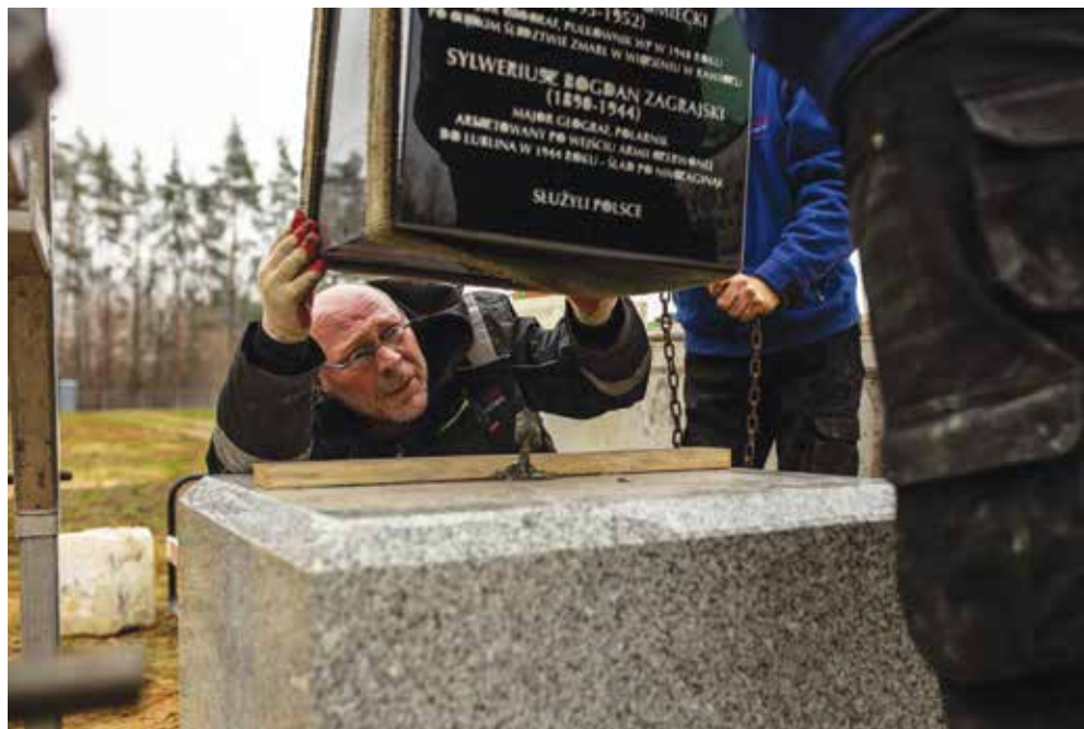
Ryc. 2. Montaż pomnika, styczeń 2023.
