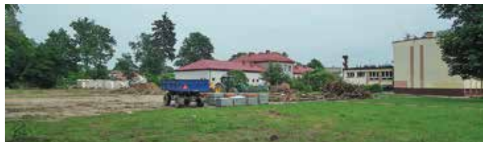
Obecny plac budowy boiska w „Czwórcie”
