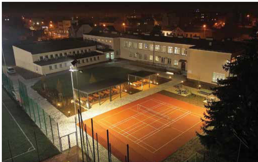
Ryc. 9. Inwestycja „Zagospodarowanie terenu przy Zespole Szkół nr 2”
